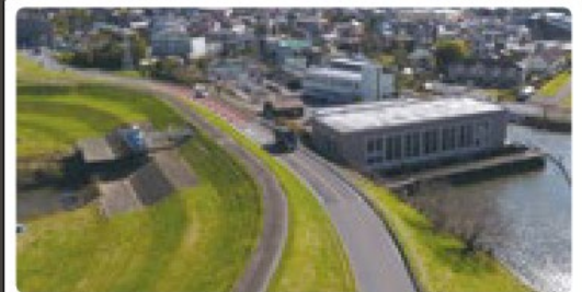
手賀排水機場
